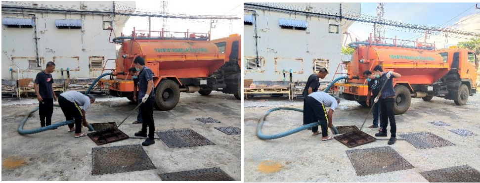
รูปที่ 2-8 รูปแสดงการสูบน้ำจากถังเกราะ
