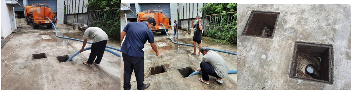
รูปที่ 2-7 รูปการสูบน้ำออกจากบ่อดักไขมัน
